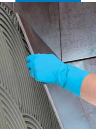
Lepení keramického velkoformátového obkladu na stěnu
